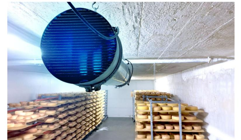
Selbst bei hoher Luftfeuchte und korrosiven Umgebungsbedingungen sorgt der sterilAir UVR-4K im Käsekeller für sporenfreie Luft.
