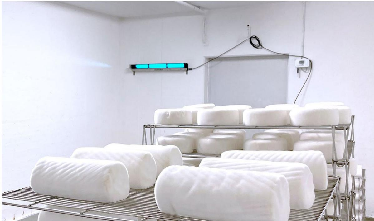
Bei der Reifung der Weichkäsespezialitäten werden Schimmelsporen in der Luft mit einem sterilAir Wandstrahler inaktiviert.
