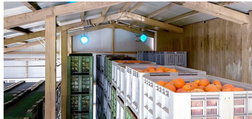
Les UVR-4K inactivent 90 % des spores résistantes de moisissure noire à chaque passage et prolongent la conservation des produits frais et des légumes de stockage.
