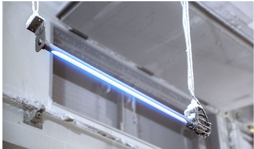
Die UVC-Module werden von der Decke abgehängt, die Elektronik befindet sich außerhalb der Gefriertrocknung
