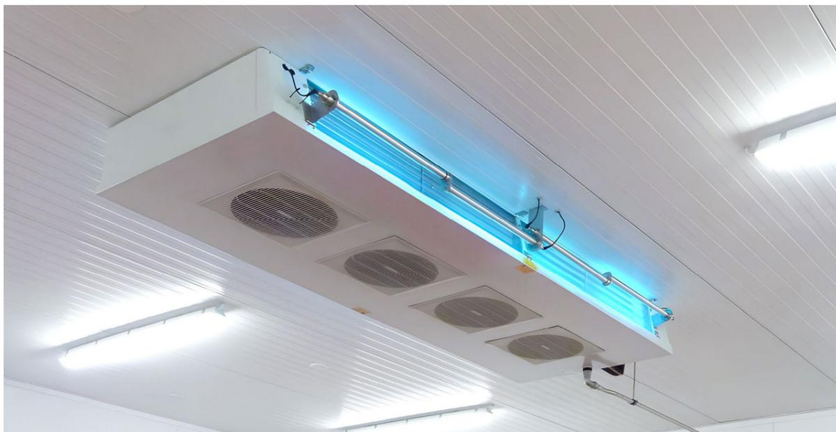
Les appareils UVC installés devant les ailettes des évaporateurs empêchent la formation de biofilm et la contamination de l'air ambiant.
