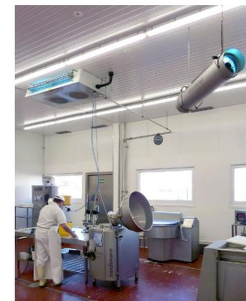
Pour les locaux sans circulation d'air, l'UVR-4K avec désinfection continue de l'air est la solution idéale.
