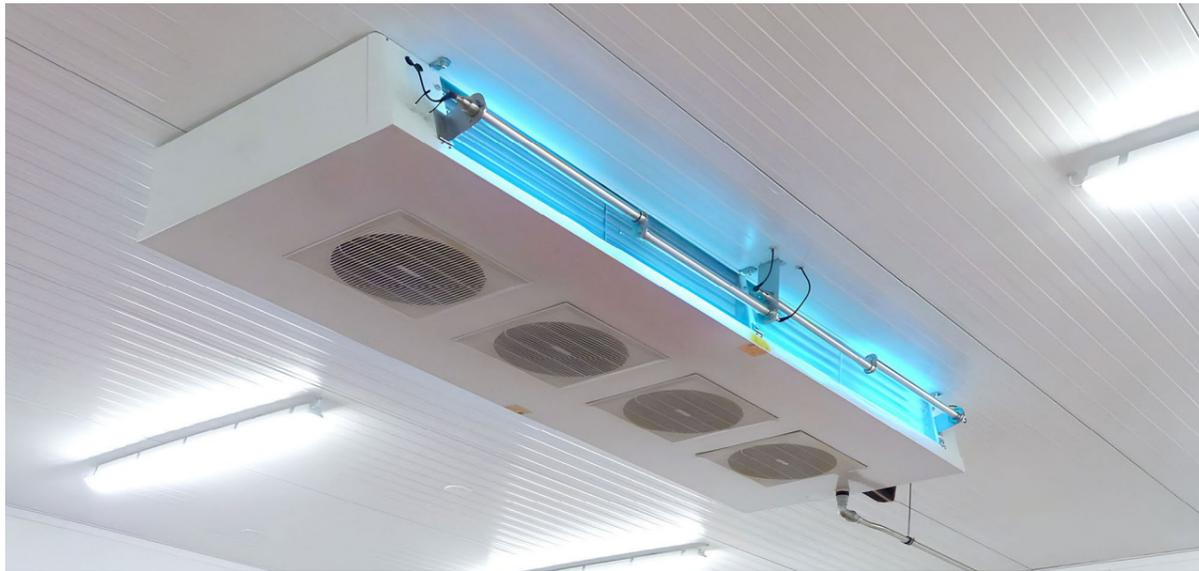
Vor Verdampferlamellen installierte UVC-Geräte verhindern die Bildung von Biofilm und die Verunreinigung der Raumluft.
